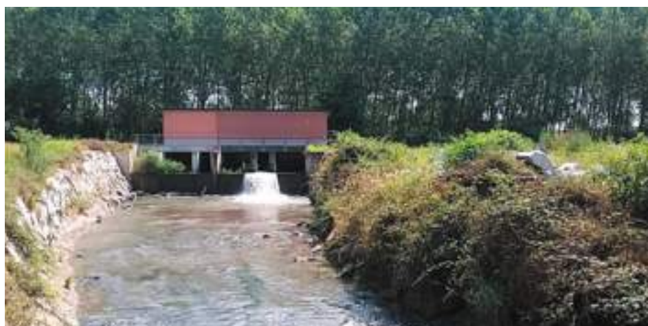
Edificio di scarico dalla Roggia Biraga - Partenza dello scaricatore del Molino Nuovo - Robbio (PV) (Fonte: Documentazione progettuale)
