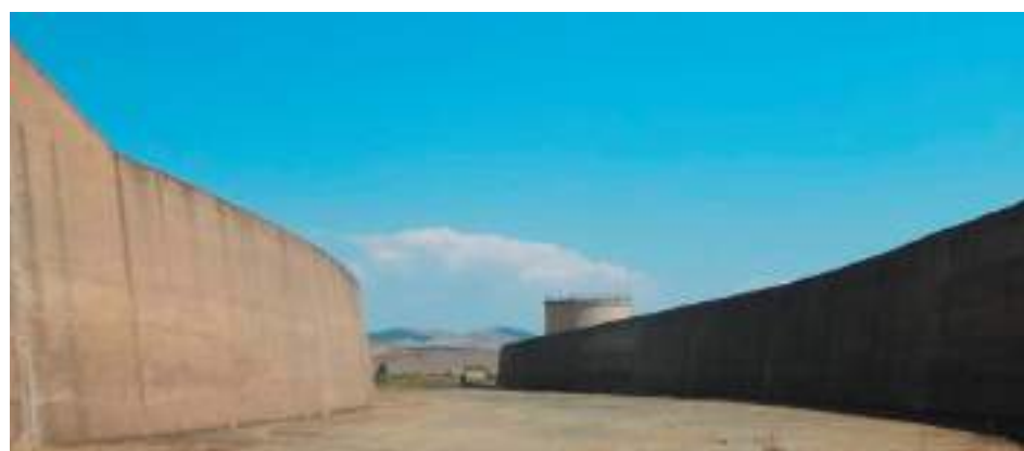
Diga di Pietrarossa (Fonte: al sito web della Regione Siciliana)
