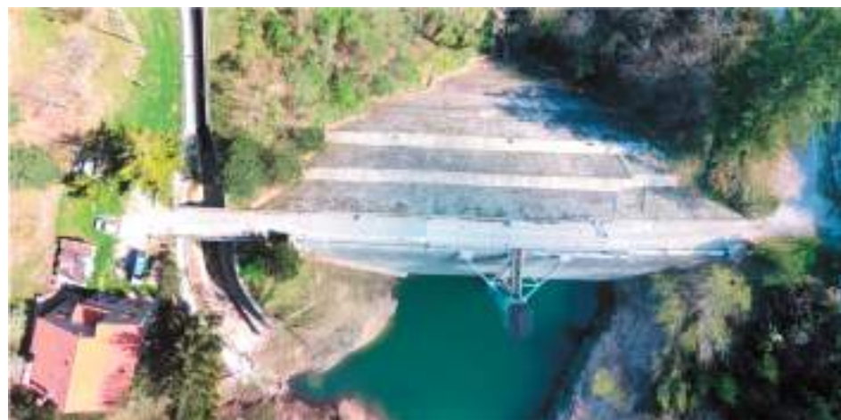
Diga Cerventosa (Fonte: relazione tecnica)
