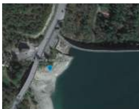
Stazione di sollevamento in sinistra orografica del lago (Fonte: documentazione progettuale)
