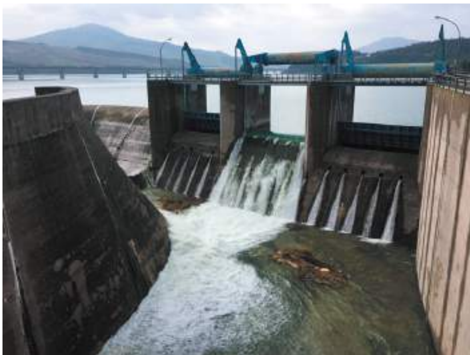
Diga Ponte Liscione (Fonte: molisenews.it)
