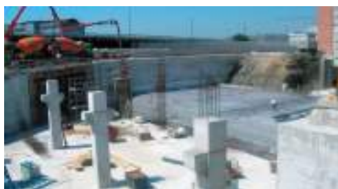
Lavori presso la centrale Tronchetto (fonte: www.veneziatoday.it )
