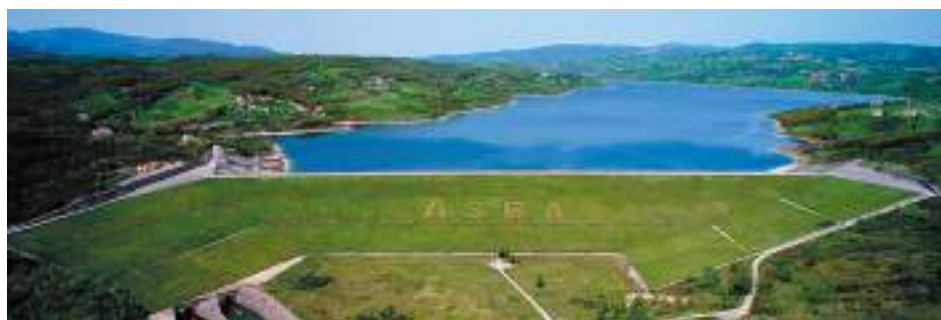
Diga di Campolattaro (Fonte: documentazione progettuale)
