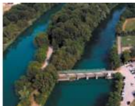
Diga di Salionze (Fonte: documentazione progettuale)
