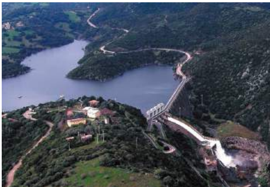
Diga del Liscia (Fonte: www.santantoniodigalluraturismo.it )
