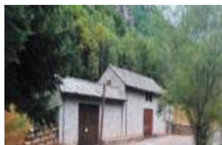
Manufatto realizzato con tecnica di ingegneria naturalistica.
