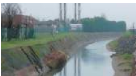
Stato del canale Adigetto tra Rasa e Lendinara (Fonte: documentazione progettuale)
