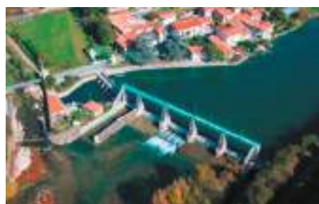
Vista aerea della traversa
