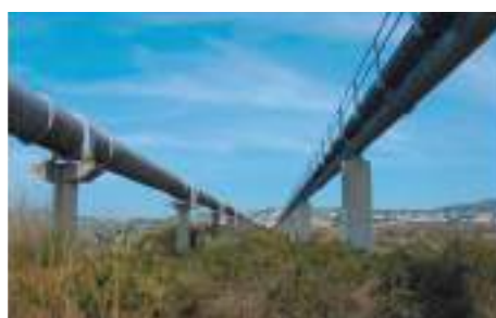
Condotte DN 1400 e DN 500 nel tratto dell'attraversamento pensile del fiume Sinni. (Fonte: relazione tecnica)
